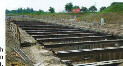
Der 620 m lange Tunnel Srejach wird durch die Firma Kostmann in Deckelbauweise hergestellt.
